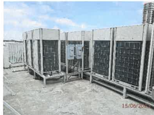
รูปที่ 2- 26 คอมเพรสเซอร์เครื่องปรับอากาศ
