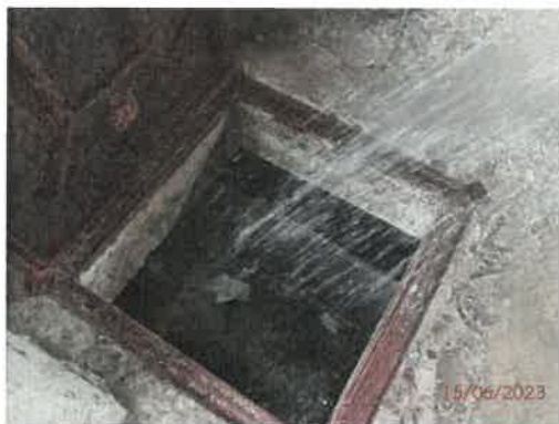
รูปที่ 2- 39 การทำความสะอาดตะแกรงบ่อดักขยะ
