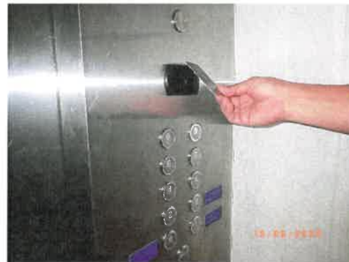
รูปที่ 2- 71 ระบบ Key Card
