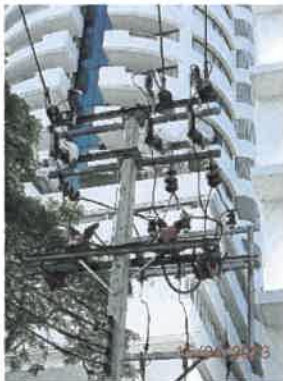
รูปที่ 2- 29 ชุดอุปกรณ์ป้องกันการระเบิดของหม้อแปลง
